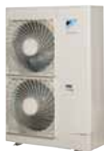
Jednostka zewnętrzna ERLQ-C WysxSzerxGłęb.: 1345x900x320
